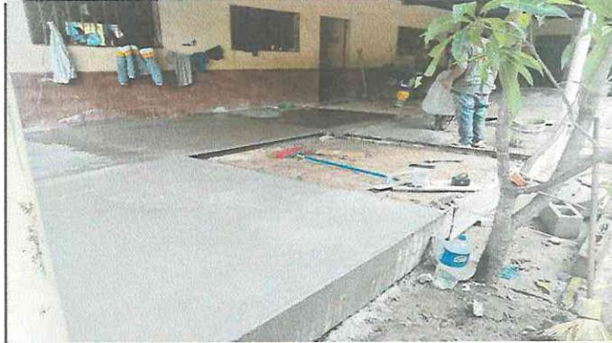
**FOTO 2: EXTRACCIÓN DE PISO DE CONCRETO EXISTENTE Y FUNDICIÓN DE PISO DE TORTA CON ACABADO ALISADO PARA EL CORREDOR.**
