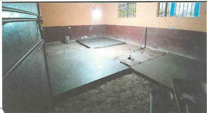
**FOTO 1: SE PROCEDE A FUNDIR EL PISO DE CONCRETO EN DOS AULAS DEL ESTABLECIMIENTO.**
