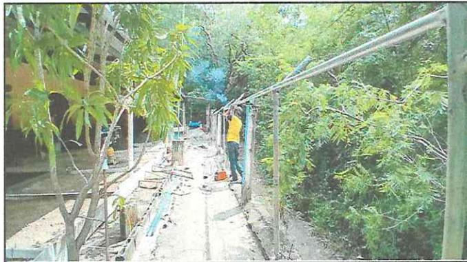
**FOTO 4: CAMBIO Y COLOCACIÓN DE MALLA EN TODO EL FRENTE Y LA PARTE LATERAL IZQUIERDA DE LA CIRCULACIÓN DEL ESTABLECIMIENTO.**
