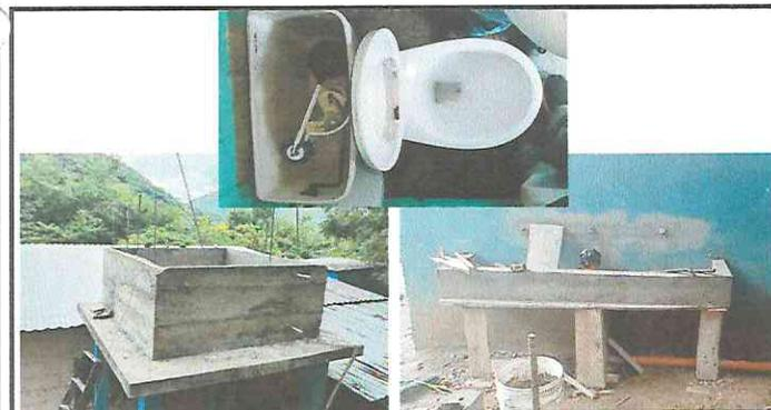
**FOTO 5: CONSTRUCCIÓN DE TANQUE DE CONCRETO, FUNDICIÓN DE LAVAMANOS CON TRES CHORROS Y REPARACIÓN DE LOS TANQUES DE LOS SERVICIOS SANITARIOS**
